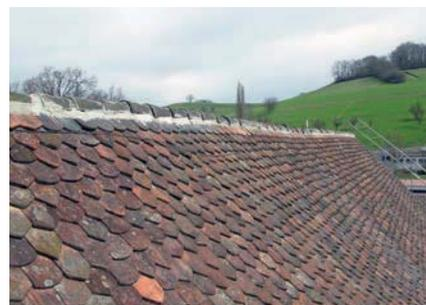
Bei der Estrichsanierung der Kirche Mandach wurden die Firstziegel vermörtelt, um das Mikroklima im Dachstock für die Wochenstube der Grauen Langohren zu verbessern.
