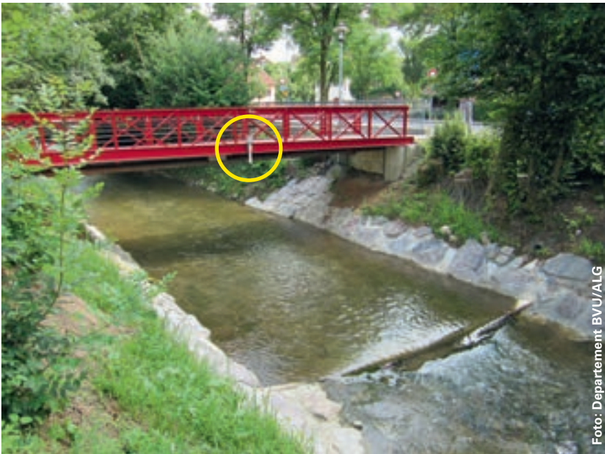
In Lengnau wird der Wasserstand der Surb mit einer Radarsonde gemessen.
