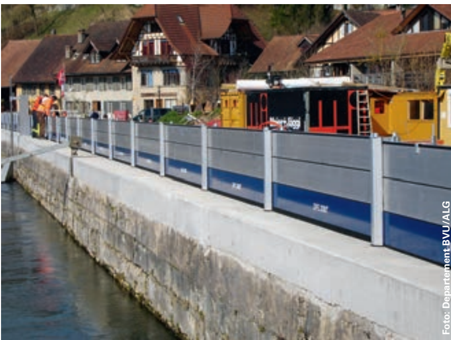
In Unterwindisch werden die mobilen Dammbalken eingebaut.
