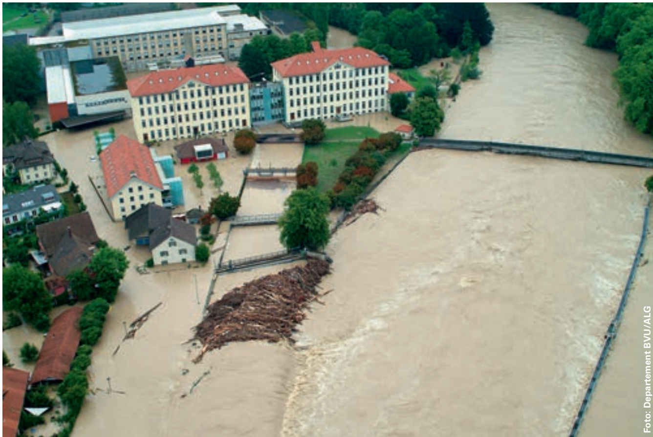
Beim Hochwasser 2005 trat die Reuss in Unterwindisch über die Ufer.
