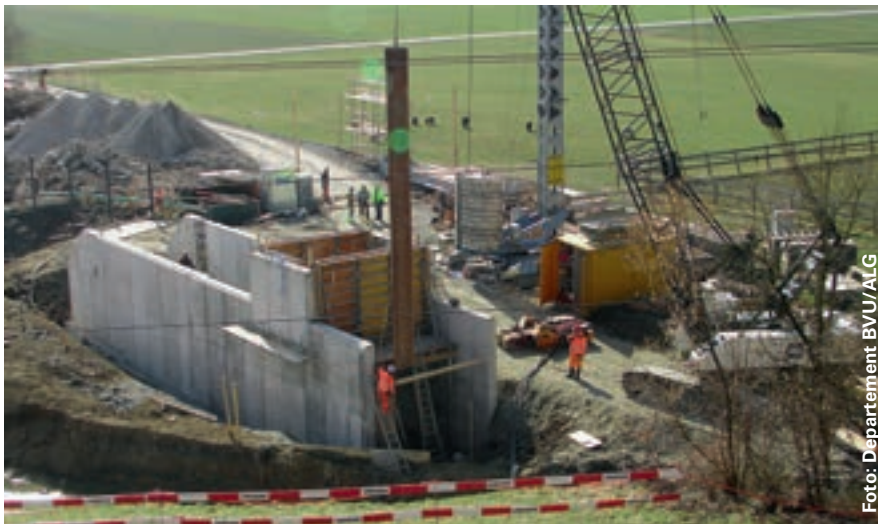
Der schachtförmige «Mönch» des Drosselbauwerks ist eine Kombination aus einem gesteuerten Durchlass (Öffnung) und einer Hochwasserentlastung (Überfall).
