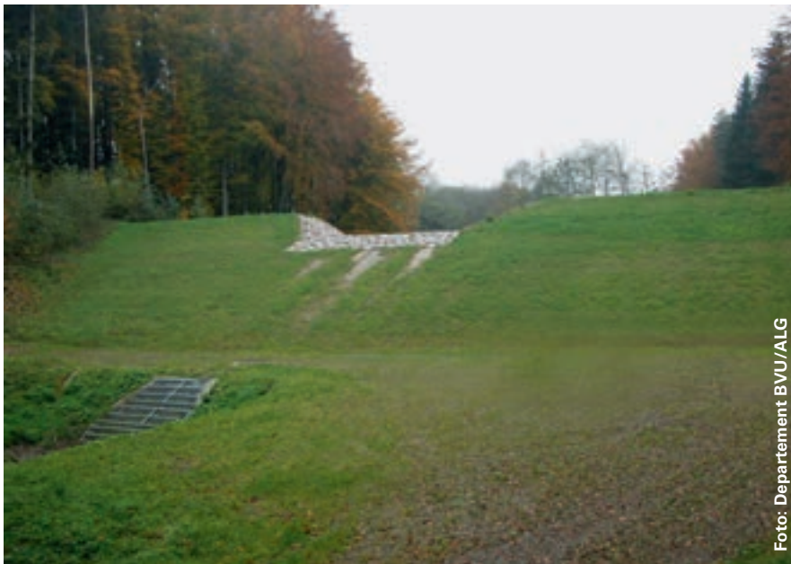
Hochwasserrückhaltebecken Drachtenloch: Schüttdamm mit Durchlasserlauf und Dammscharte
