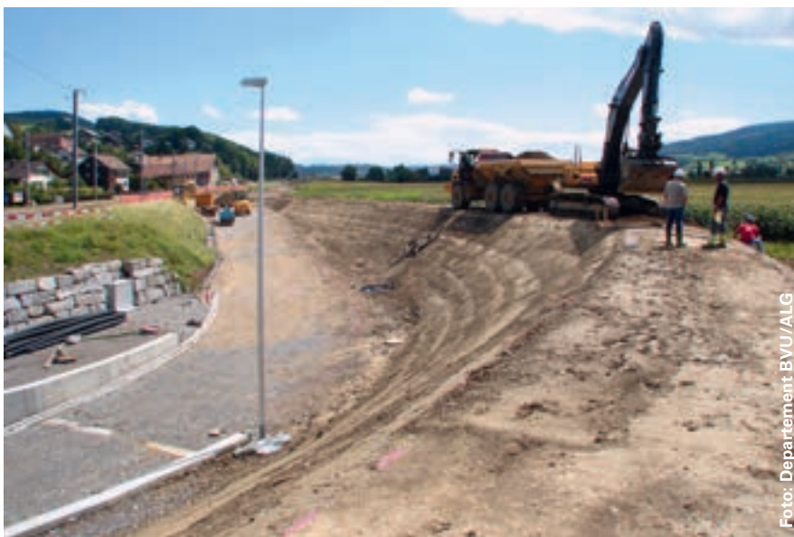
Der Seitendamm wird aus Aushubmaterial der Wynarenaturierung gebaut.
