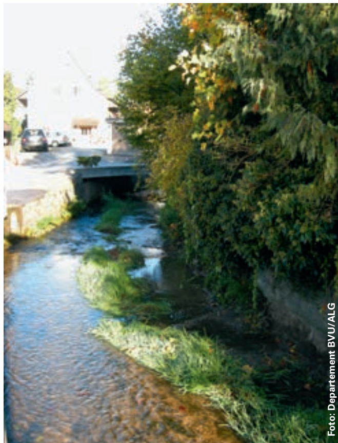
Differenziertes Entfernen von Auflandungen (Wintersingerbach in Magden)
