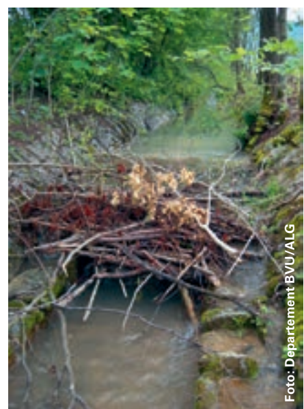
Schwemmholz muss entfernt werden, damit es bei Hochwasser nicht zu einem Rückstau kommt (Effingerbach in Effingen).
