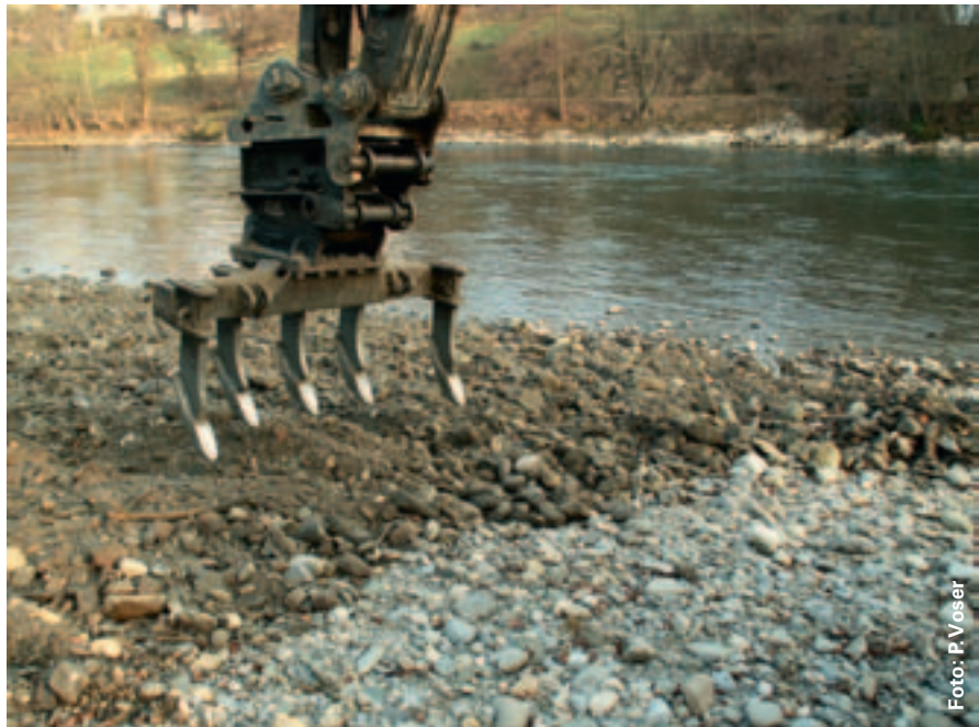
Kieslockerung: Bei Niederwasser wird eine kolmatierte Kiesbank für die kommende Laichsaison hergerichtet.
