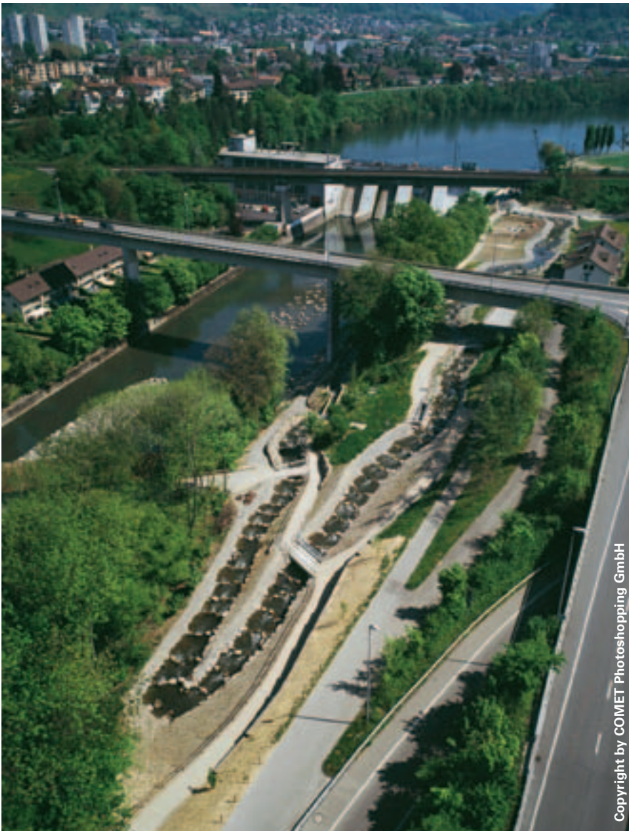
Bis 2008 war die Fischwanderung beim Kraftwerk Wettingen blockiert. Nun besitzt das Kraftwerk eine lange Fischaufstiegshilfe.
