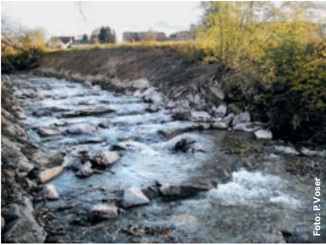
Die Blockrampe Helbrig vernetzt seit 2004 in der Pfaffnern zwei lange Bachabschnitte.
