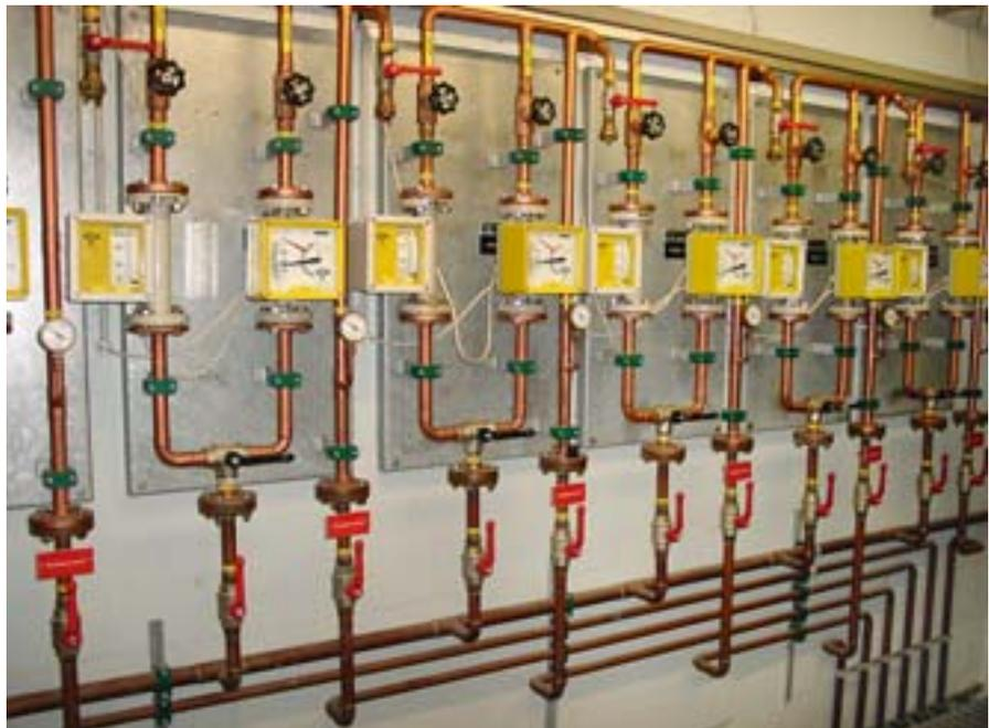
*Armaturen und Ventile zur Steuerung der Belüftungsanlage im Betriebsgebäude der Seebelüftung am Seezopf Meisterschwanden*
