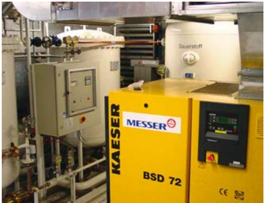
*Anlage zur Produktion von Sauerstoff mittels Druckwechsel-Adsorption im Betriebsgebäude der Seebelüftung am Seezopf Meisterschwanden.*
