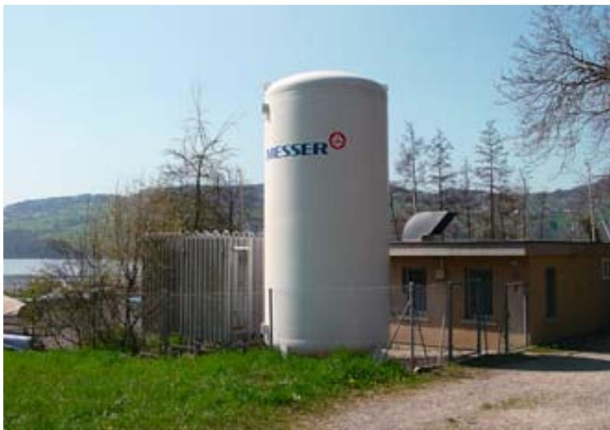
Im Seezopf bei Meisterschwanden befinden sich das Betriebsgebäude der Seebelüftung, ein Lagertank für flüssigen Sauerstoff und die Kaltvergaseranlage, um den flüssigen Sauerstoff zu verdampfen.
