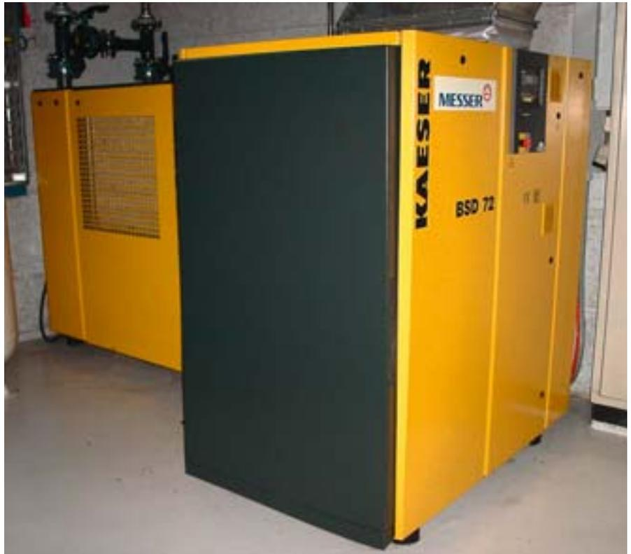
*Druckluftanlage mit Kältetrockner im Betriebsgebäude der Seebelüftung am Seezopf Meisterschwanden.*
