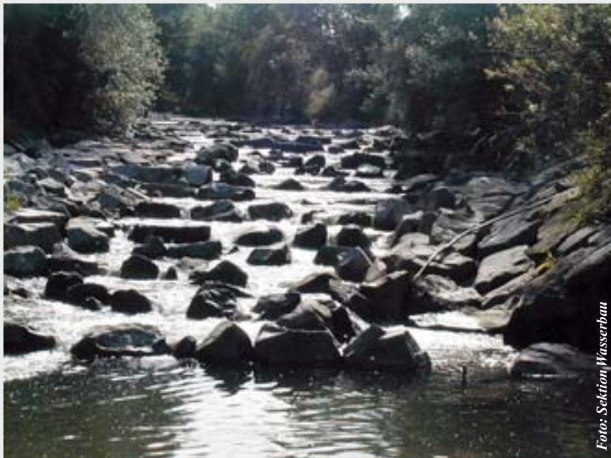
Das Grienwuh vor und nach dem Umbau
