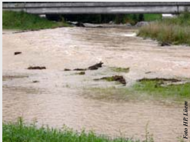
Muhen: Überlauf in die Flutmulde
