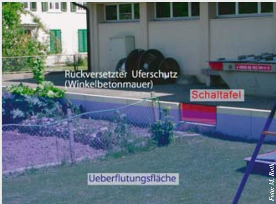
Der rückversetzte Uferschutz in Form einer einfachen, günstigen Winkelbetonmauer schützt die im Hintergrund liegende Wohn- und Gewerbezone. Die Gartenanlage im Vordergrund liegt bei einem mittleren Hochwasser im Überflutungsbereich der Bünz. Die Aussparung in der Winkelbetonmauer dient im Normalbetrieb dem ungehinderten Zugang. Im Ereignisfall kann diese Aussparung mit einer Schalttafel geschlossen werden.
