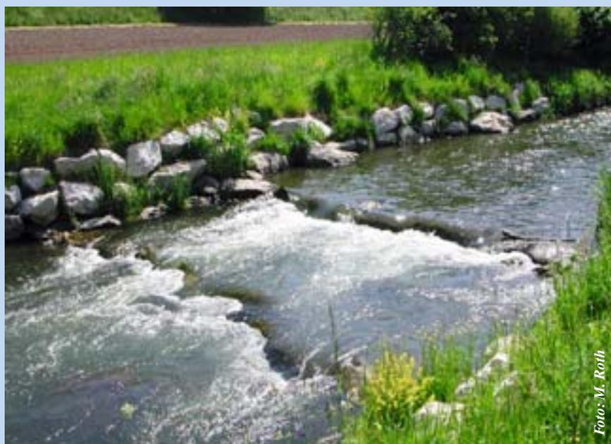
Die Riegelrampe besteht aus quer stehenden Steinreihen und dient der Stabilisierung des Bachbettes.
