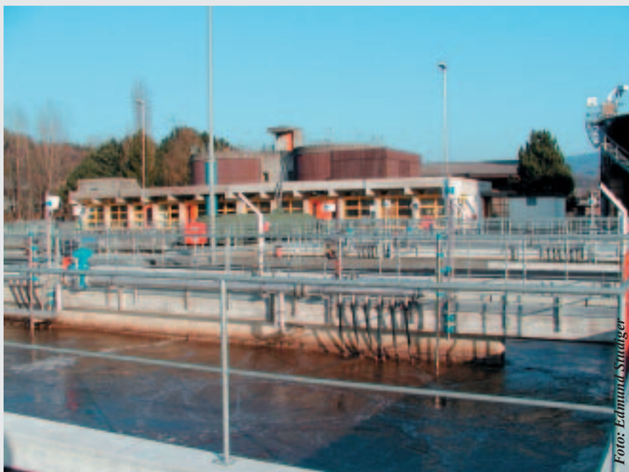
An die ARA Oberes Surbtal in Unterehrendingen sind Ober- und Unterehrendingen, Schneisingen sowie die Zürcher Gemeinden Nieder- und Oberweningen, Schleinikon, Schöfflisdorf angeschlossen.
