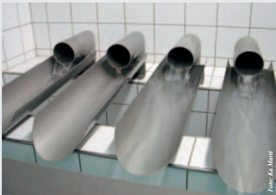
Quellwassereinläufe in der Brunnstube Obertel in Suhr
