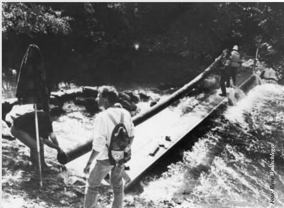
Das Verteilrohr aus Kunststoff wird in das fertig verlegte Beton-Einleitwerk eingelegt.
