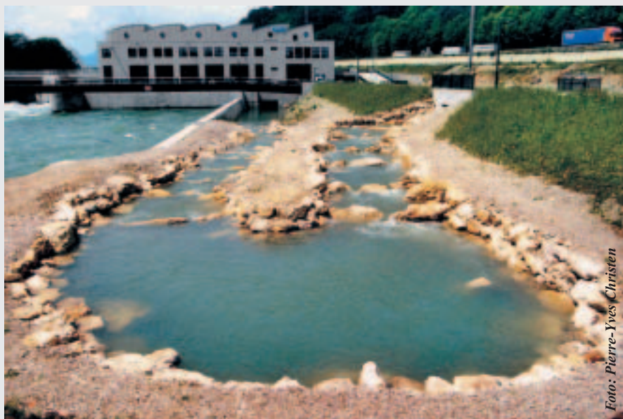
Wasserkraftwerke stellen für Fische ein Hindernis dar. Das Kraftwerk Ruppoldingen hat deshalb einen Fischpass gebaut, der den Fischen den Aufstieg im Gewässer ermöglicht.
