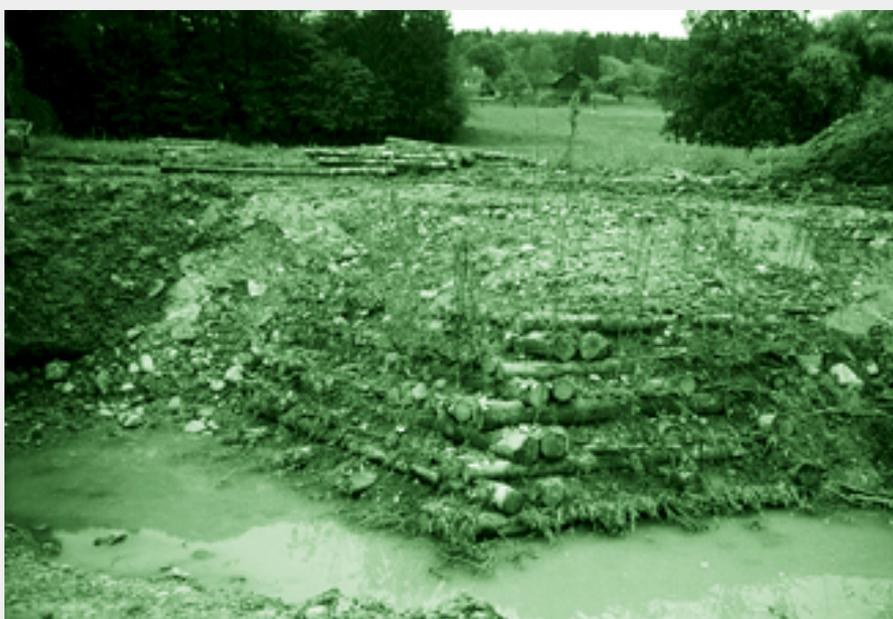
Holzgrünschwellenbuhne mit einer Granitsteinsicherung bis auf etwa zwei Meter Tiefe.
