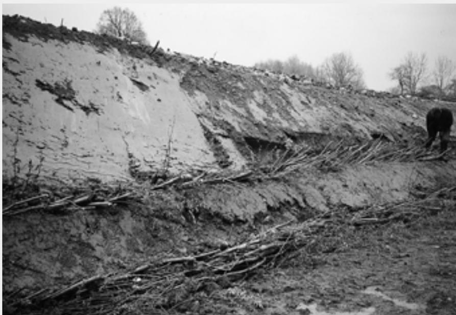
Der Böschungsfuss wurde mit Faschinen gesichert.
