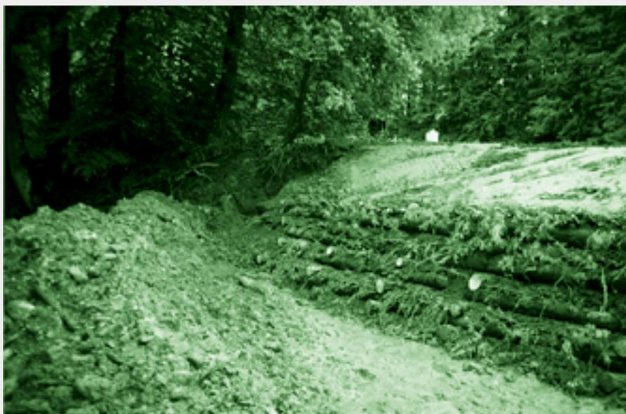
Über der Steinsicherung wurden Schwellen aus Holz eingebaut und später bepflanzt (Holzgrünschwellen).
