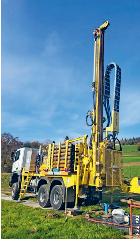
Die neue Grundwassermessstelle in Endingen wurde neu gebohrt und mit einem Filterrohr (blau im Bild) ausgebaut, rechts das zugehörige Bohrprofil. Im gelben Bereich des Profils wurde Filterkies eingebracht und der violette Bereich mit Ton abgedichtet.
