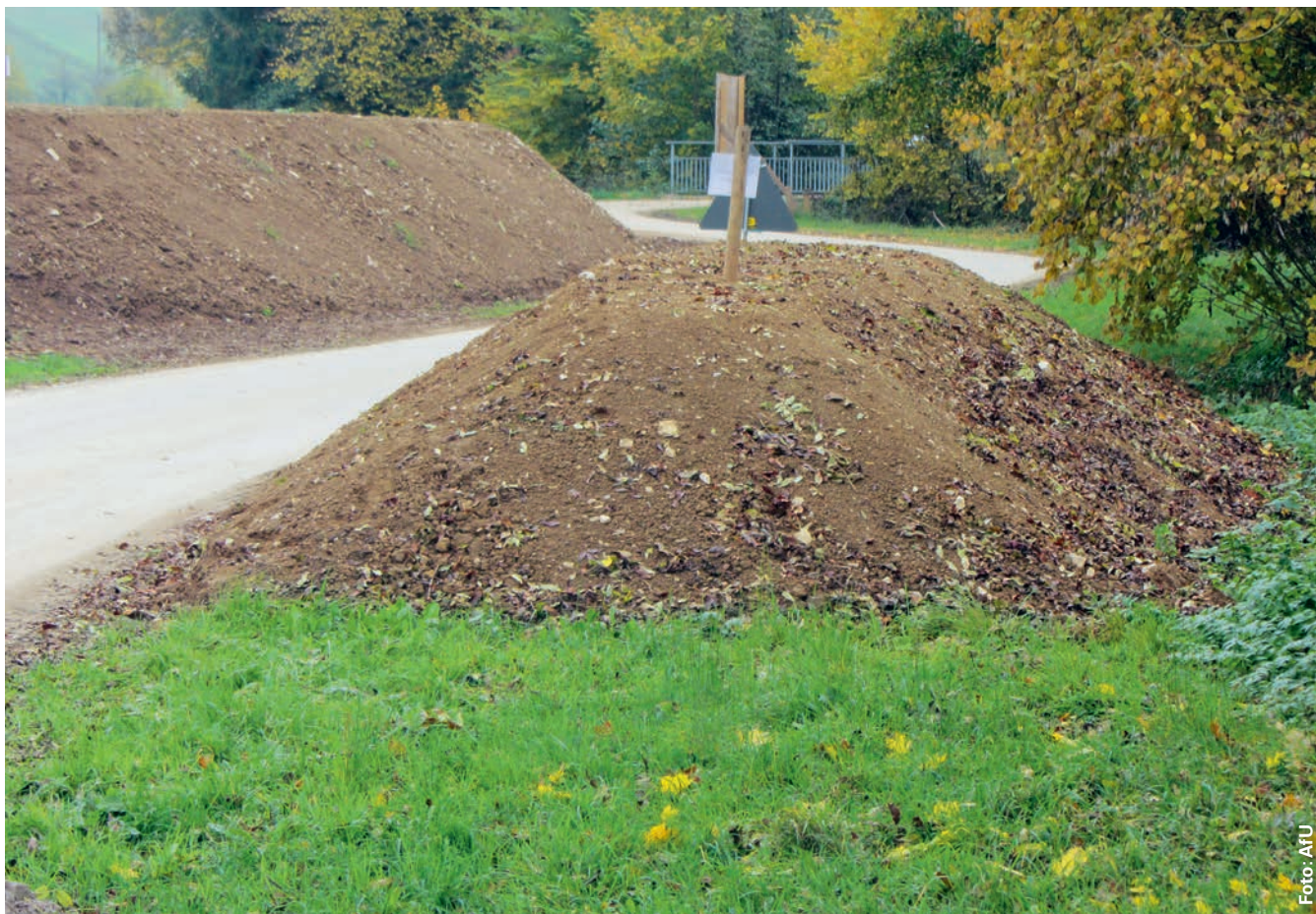
Bei vielen Bauprojekten fällt Bodenaushub an, der abtransportiert werden muss. Für die Wiederverwendung ist es wichtig, zu wissen, ob das Material mit Schadstoffen belastet ist.
