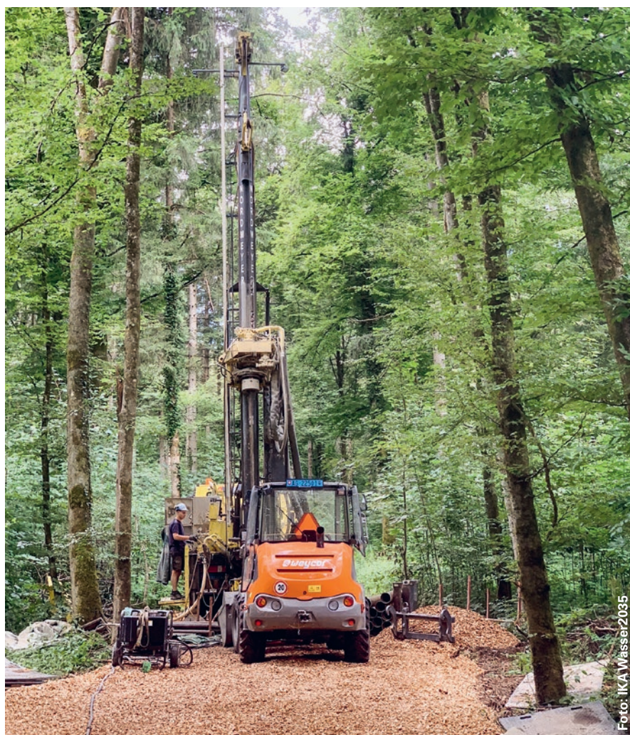
2020 wurde im Gebiet Zimberhübel eine erfolgreiche Sondierbohrung durchgeführt. Es besteht hier eine Wasserförderkapazität von 14'400 Kubikmeter pro Tag.
