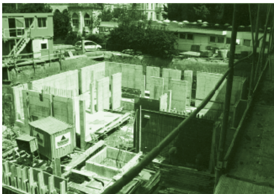
Die Arbeiten beim Neubau schreiten zügig voran.
