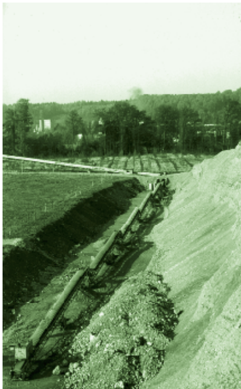
Der Transport zur Aufbereitungsanlage erfolgt mittels Förderband.
