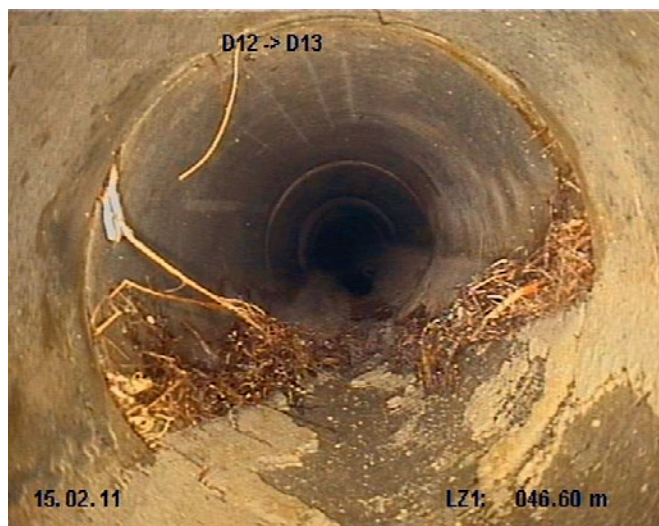
Schadhafte Sammelleitungen (links: Wasserinfiltration; rechts: Wurzeleinwuchs) sind zu sanieren oder zu erneuern.
