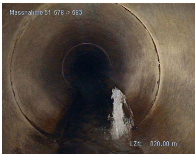
Schadhafte Sammelleitungen (links: Wasserinfiltration; rechts: Wurzeleinwuchs) sind zu sanieren oder zu erneuern.
