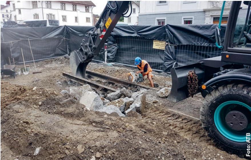
Zum Schutz der Anwohnenden können Baubewilligungsbehörden zeitliche Betriebseinschränkungen für lärmintensive Bauarbeiten verfügen.
