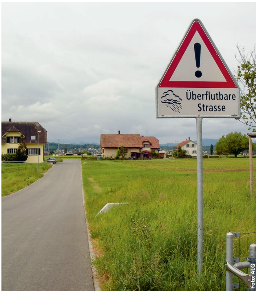
Hochwasserüberflutungskorridor in Muhlen: Wird die Gerinnkapazität der Suhre erreicht, wird der Korridor überflutet und das Wasser wird kontrolliert abgeleitet.
