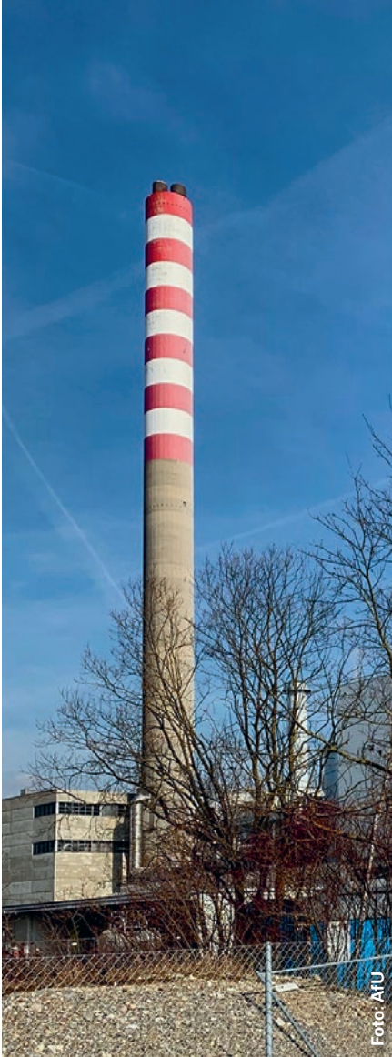
Mit einem Kamin werden Abgase über Hindernisbereiche hinaus in höhere Luftschichten abgeleitet.
