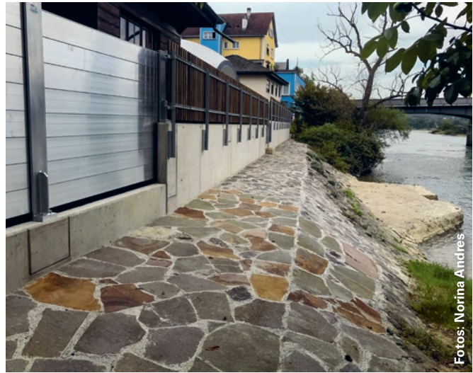
Unterhalb des SBB-Viadukts wurden neue Mauern gebaut mit Vorrichtungen für ein Dammbalkensystem. Bei einem drohenden Hochwasser können die Aluminiumbretter einfach auf die Mauer aufgesetzt werden. So wird den Anwohnenden die Sicht auf den Rhein nicht permanent durch hohe Mauern eingeschränkt.
