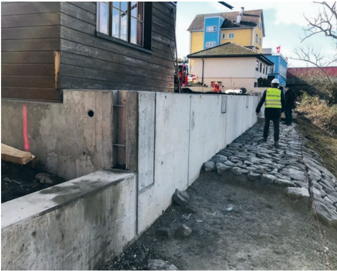
Unterhalb des SBB-Viadukts wurden neue Mauern gebaut mit Vorrichtungen für ein Dammbalkensystem. Bei einem drohenden Hochwasser können die Aluminiumbretter einfach auf die Mauer aufgesetzt werden. So wird den Anwohnenden die Sicht auf den Rhein nicht permanent durch hohe Mauern eingeschränkt.
