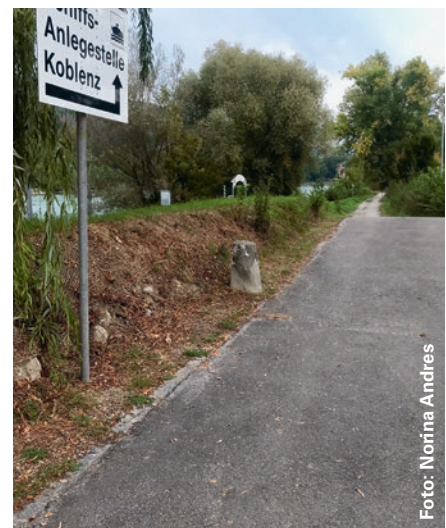
Flussaufwärts des SBB-Viadukts wurde der Damm am Ufer des Rheins auf einer Länge von 70 Metern erhöht.
