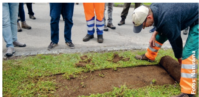
Der Sodenschneider zieht ein Messer durch den Boden und schneidet so die bestehende Vegetation auf (links). Der Rasen kann dann aufgerollt und einfach entfernt werden (rechts). So ist der Boden für eine sofortige Aussaat bereit.
