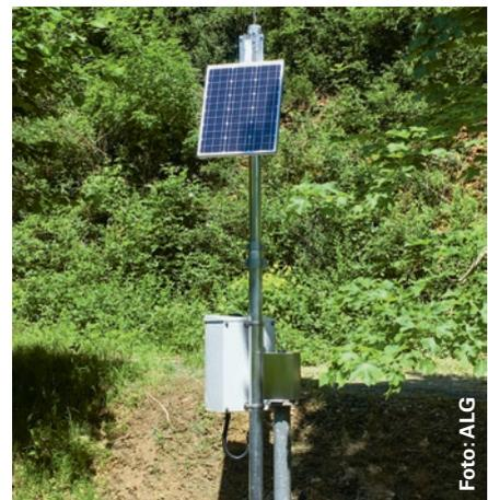
Umrüstung B-Netz+: Die kleineren Messstationen werden neu mit Solarenergie betrieben (Erzbach in Erlinsbach).
