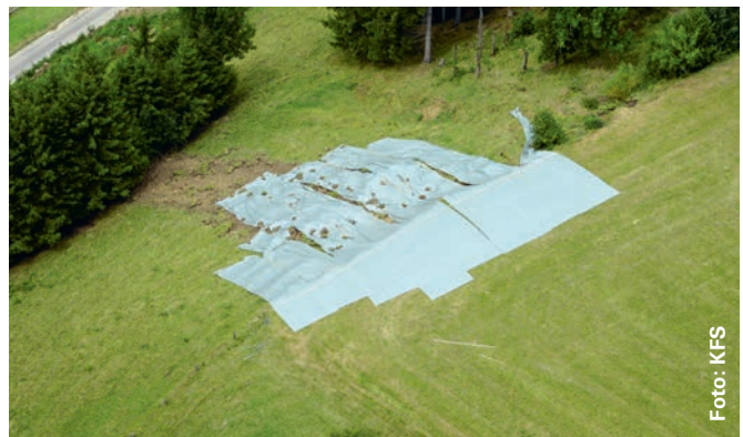
Um ein weiteres Abrutschen zu verhindern, wurde als Sofortmassnahme der Hangrutsch vom 8. Juli 2017 in Bottenwil mit Plastikfolie abgedeckt (rechts).
