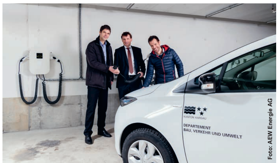
Der Kanton Aargau hat an den Standorten Telli und Buchenhof eine Ladestation für Elektrofahrzeuge für Mitarbeitende und Externe eingerichtet.
