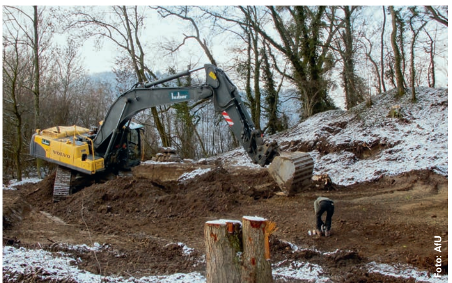
Das belastete Kugelfangmaterial wird schichtweise abgetragen, um die Aushubkubatur so gering wie möglich zu halten. Mit einem mobilen XRF-Messgerät (Röntgenfluoreszenz-Spektrometer) wird durch die Fachbauleitung laufend geprüft, ob das angestrebte Sanierungsziel erreicht ist.
