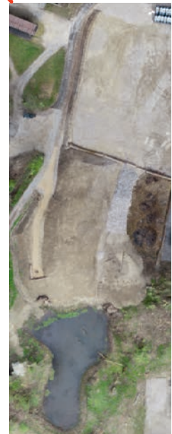
Das Areal des 300-m-Kugelfangs nach Abschluss der Endgestaltung: Der Schachenweiher ist unten im Bild, die Aussichtskanzel in der Bildmitte und der abgetragene Kugelfang oben im Bild erkennbar.
