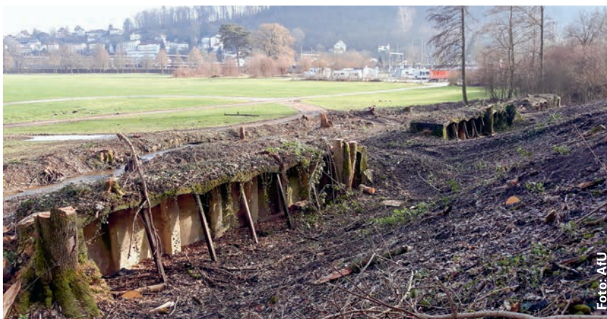
Beim «alten Chugelefänger» wurden nach den Rodungsarbeiten die zwischen dem Roggenhuserbach und dem Kugelfang noch vorhandenen Schutzunterstände rückgebaut.
