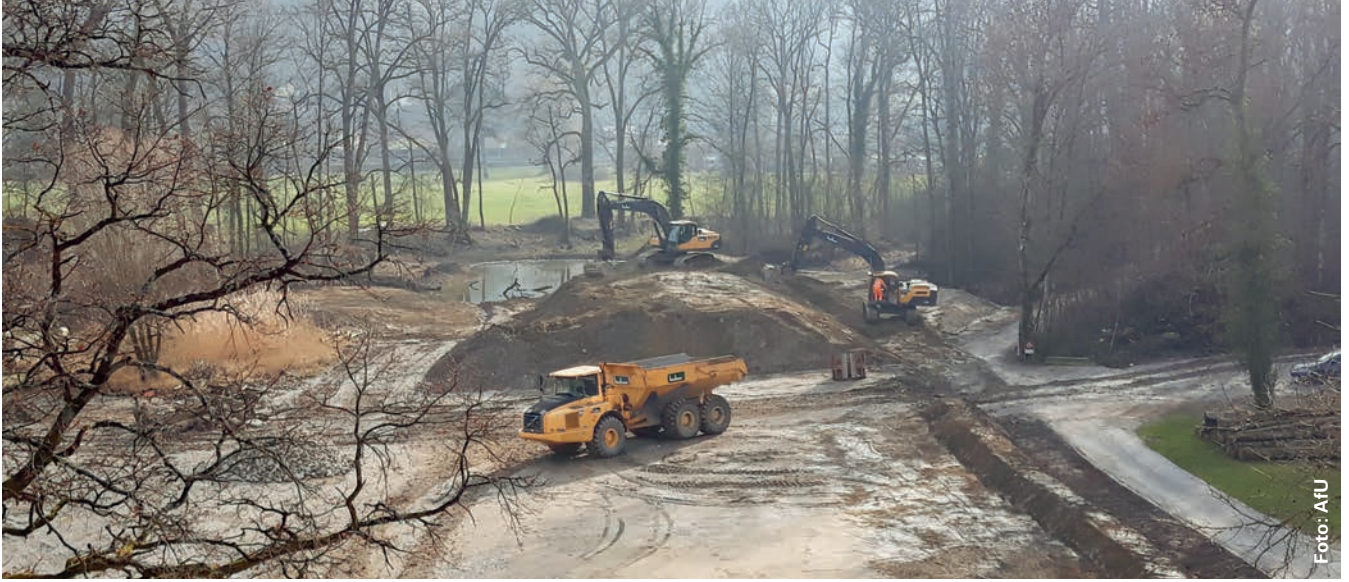
Beim 300-m-Kugelfang wurde der nördliche Teil des Kugelfangs vollständig abgetragen. Im südlichen Teil wurde für Naturbegeisterte eine Aussichtskanzel mit Sicht auf den Schachenweiher aufgeschüttet.
