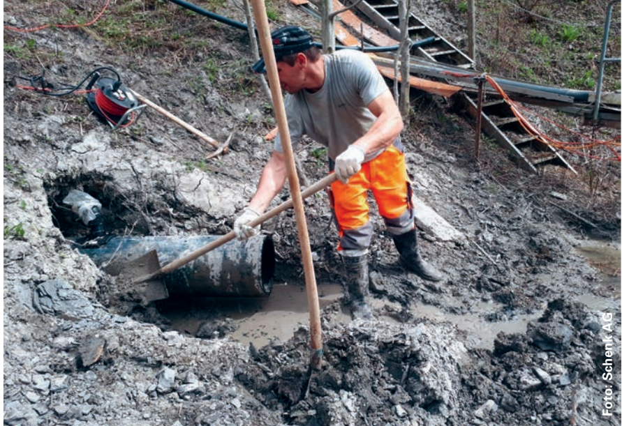
Damit die Grube bei Regenfällen natürlich entwässert wird, wurde eine Leitung in den Grubendamm eingebaut.
