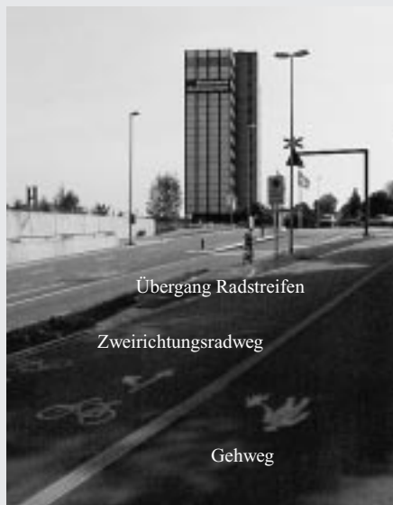
Kombinierter Rad- und Gehweg, Übergang zu einem Radstreifen
