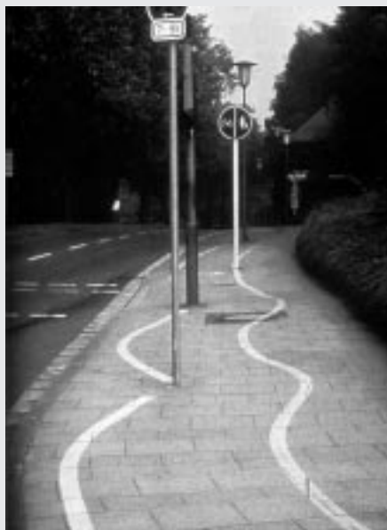
Kombinierter Rad- und Gehweg oder die Kunst der Markierung, Slalomfahren erlaubt, die Stangen stehen bereits (Beispiel aus Deutschland)
