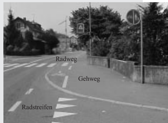
Kombinierter Rad- und Gehweg, der Veloverkehr ist im Einrichtungsverkehr auf dem von der Strasse niveaumässig abgesetzten Gehweg geführt.
