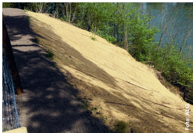
Mögliche Sanierungsmassnahmen: Holzkasten, Elementwand, Drahtgitterkörbe und Erosionsschutzmatten. Alle Methoden haben ihre spezifischen Vor- und Nachteile.
