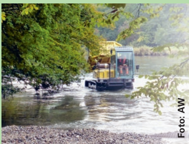
Anlegung einer Kiesinsel: Diese soll dann durch Hochwasser abgetragen werden.
