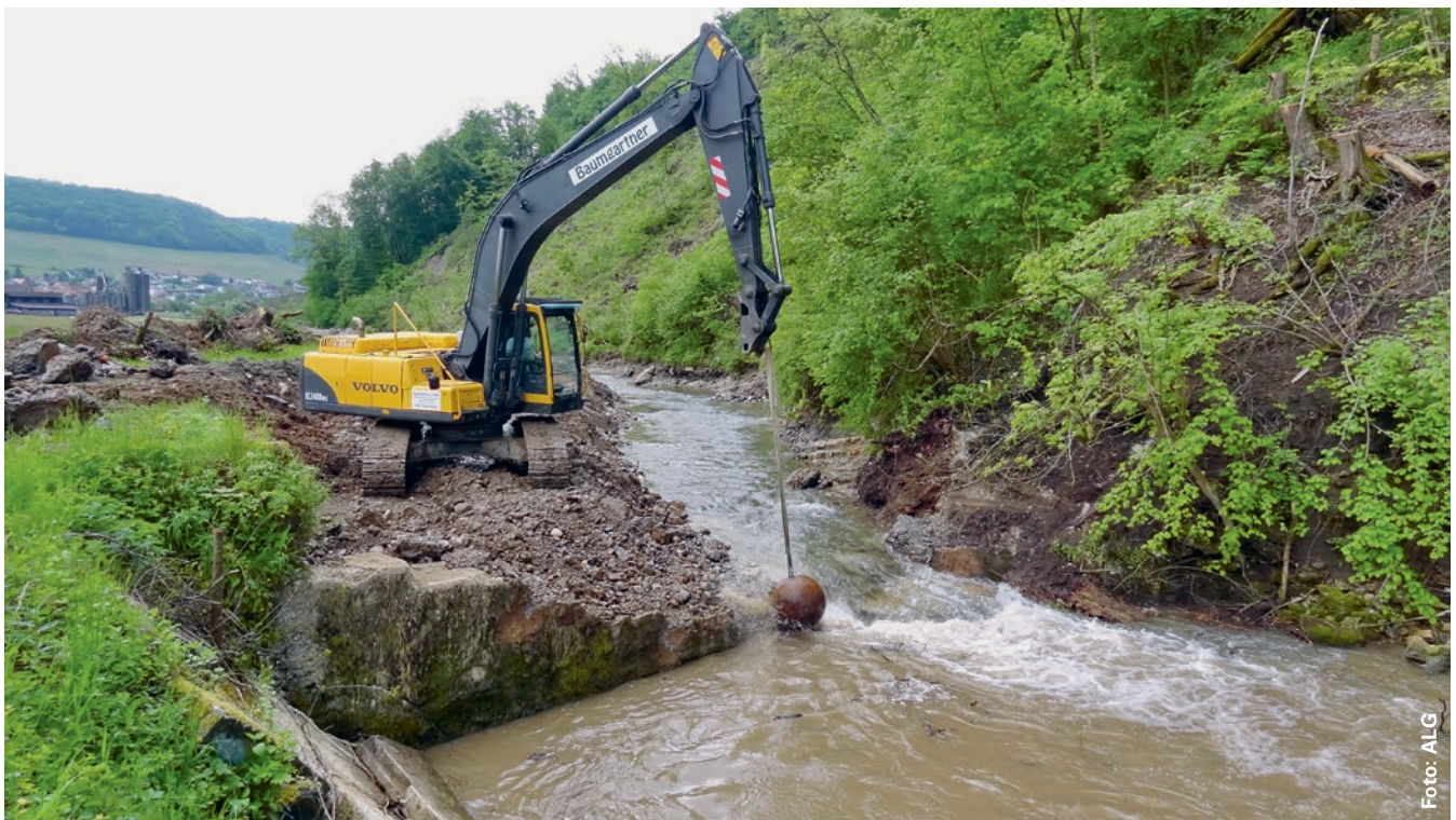
Mit schwerem Geschütz wurde dem alten Wehr zu Leibe gerückt. Der künstliche Stauraum war bereits verschwunden. Insgesamt dauerten die Bauarbeiten rund zwei Monate.
