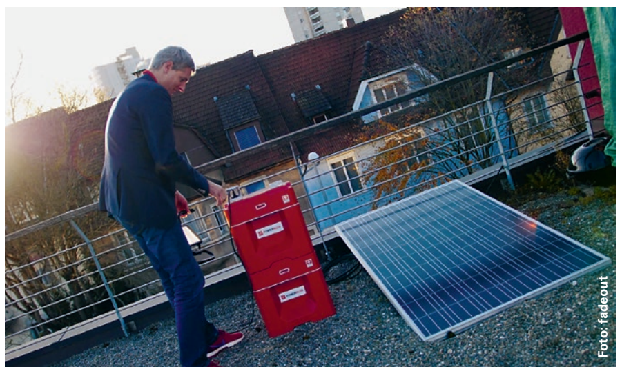
Alessandro Medici testet die Power-Blox auf dem Dach seiner Firma.
