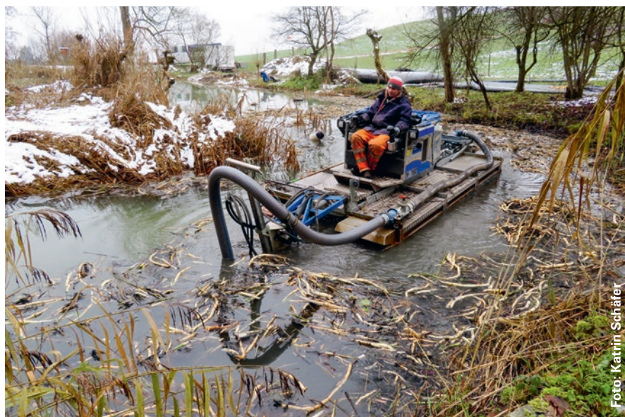
Mit dem manuell gesteuerten amphibischen Saugbagger wird der aufgewühlte Schlamm aus dem Looweier gesaugt.
