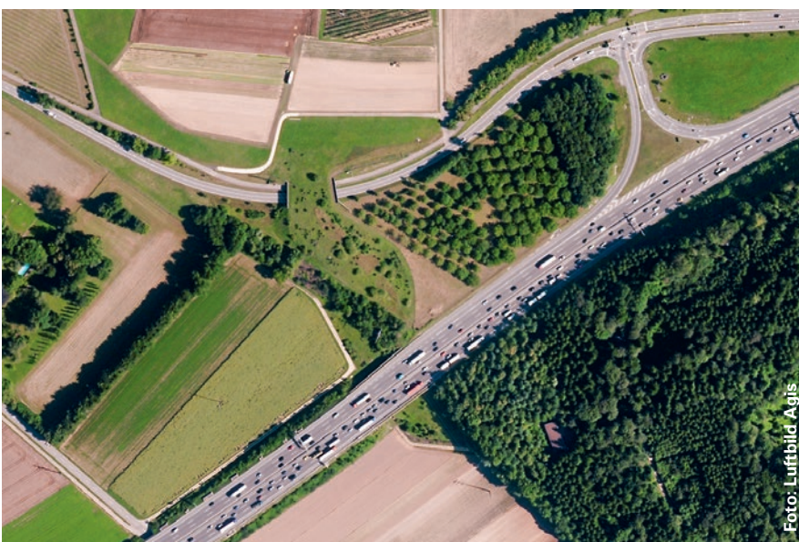
Luftbild 2014: Sichtbar sind die Wildtierunterführung der A1 und die Grünbrücke beim Baregg.
