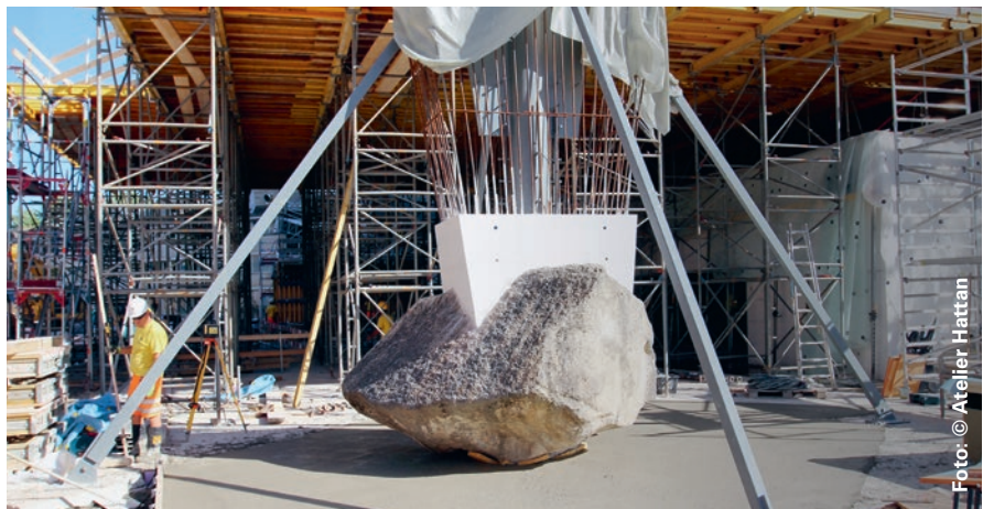
Der Findling während des Baus: Für die Tragkonstruktion musste der Stein ausgebohrt werden, um die Stütze des Vordachs mittels Stahlträger zu sichern.
