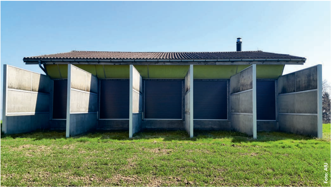
Lärmschutzwände dämmen den Mündungsknall und je nach Länge auch den Geschosknall (Beispiel Buttwil).
