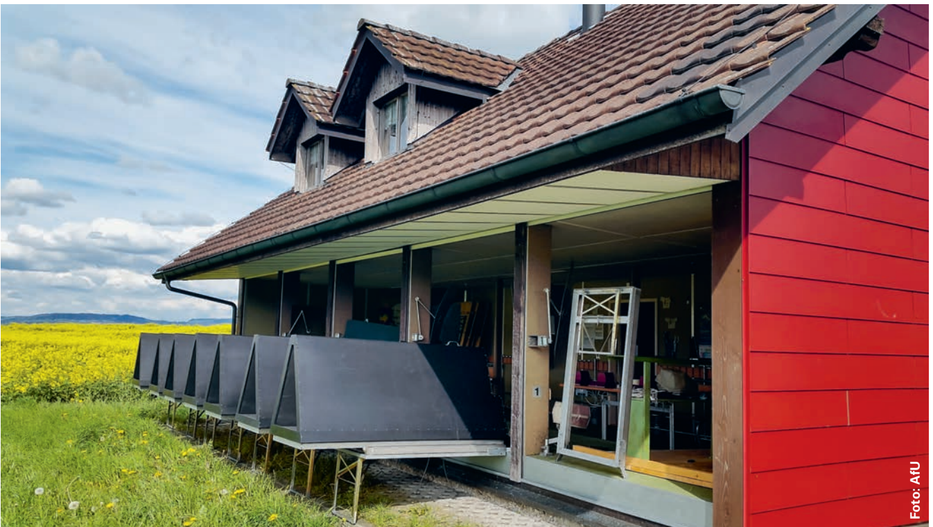
Mit Schallschutztunnels kann der Mündungsknall vor und hinter dem Schützenhaus massiv verringert werden (Beispiel Abtwil).
