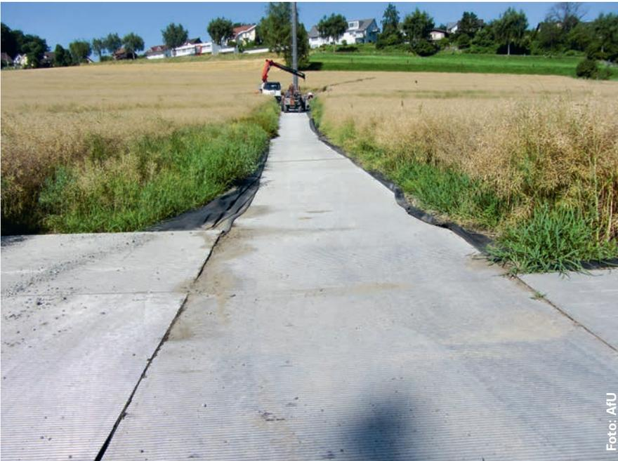
Je nach Dauer der Baustelle, Witterung, Anzahl Überfahrten und Topographie eignet sich ein anderer Typ von Baupiste. Für den Ersatz eines Betonmastes einer Stromleitung wurden durch das Elektrizitätswerk und die bodenkundliche Baubegleitung zusammen mit dem Unternehmer anstelle einer Kiespiste Aluminiumplatten verlegt. Im vorliegenden Fall hat sich dieses System aufgrund der wenigen Überfahrten und der sehr kurzen Zeitdauer bewährt.
