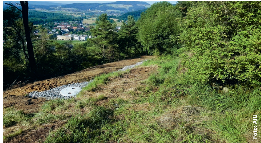
Gefasste Quelle mit Betondeckel
