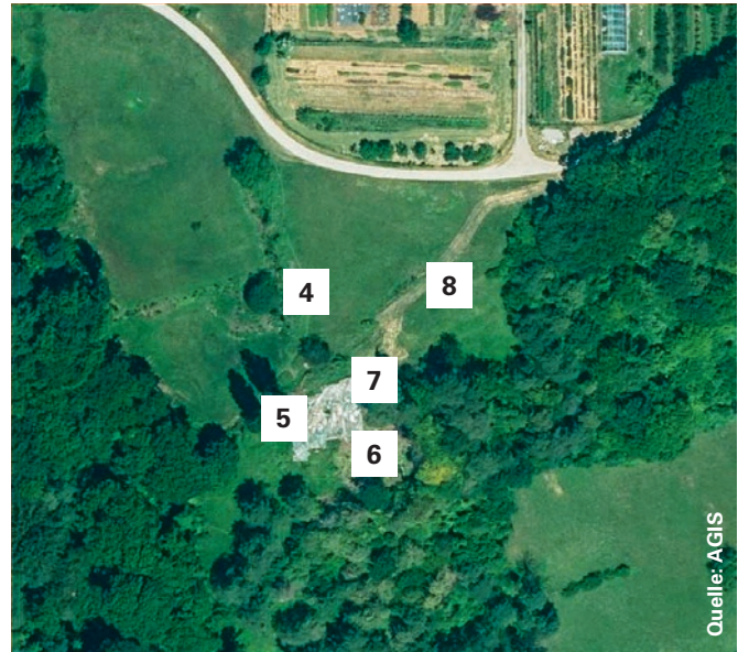
Situation nach dem Hangrutsch: Verschiedene Sanierungsmassnahmen wurden ausgeführt (Aufnahme Juni 2016).
