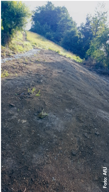
Instand gestellte Rutschfläche: Es wurde eine neue Böschung angelegt.
