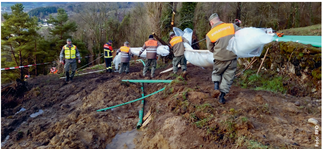
Sofortmassnahmen unter Einsatz des Regionalen Führungsorgans und des Zivilschutzes am 12. Februar 2016: Um das Wasser von der Rutschmasse abzuleiten, wurden als Provisorium PVC-Rohre verlegt.
