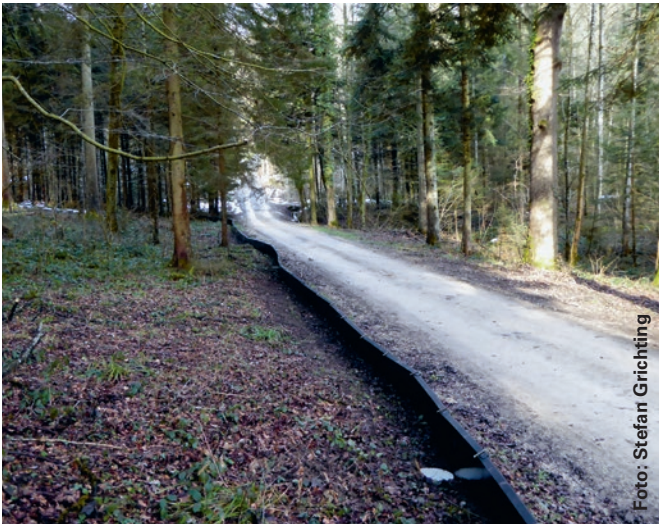
2015 wurde ein Amphibienzaun aus Kunststoffplatten der Firma Deltatec AG mit vergrabenen Kübeln verwendet.
