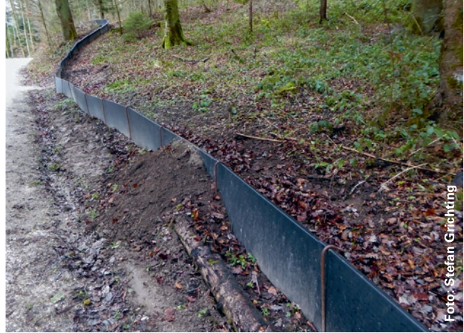
Damit die Tiere bei der Rückkehr vom Laichgewässer in den Landlebensraum nicht am Amphibienzaun scheitern, wurden Kletterrampen aufgeschüttet.
