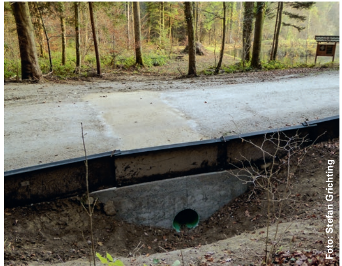
Im November 2015 wurden zwei fixe Amphibiendurchlässe zur Querung der Maurtalstrasse gebaut. Hier der Eingang Ost mit dem Laichgewässer im Hintergrund.
