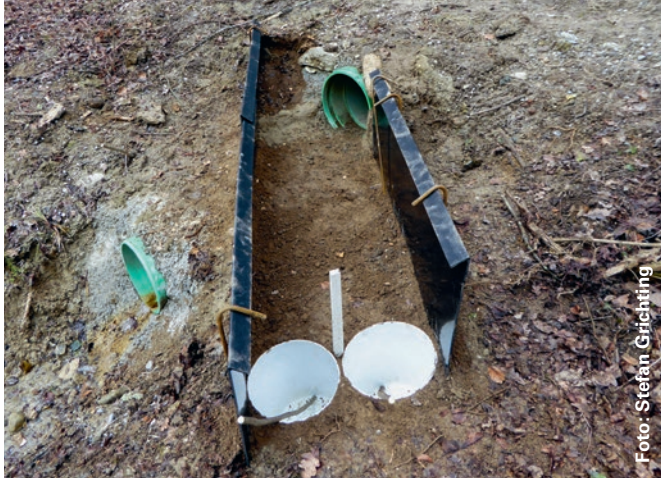
Ansicht des Ausganges des westlichen Durchlasses (obere Röhre) mit zwei vergrabenen Auffangkübeln inklusive Bachdurchlauf (untere Röhre)
