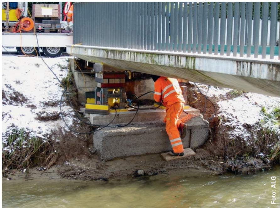
An der Wehrlistrasse in Wohlen wurde die Fussgängerbrücke mit hydraulischen Pressen angehoben. Dann wurden die Fundamente aufbetoniert und die Brückenplatte auf den erhöhten Widerlagern abgesetzt.
