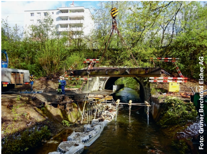
Die alte Brückenplatte der Fussgängerbrücke Junkholz in Wohlen (links) wurde durch einen neuen Stahlbauträger (rechts) ersetzt.
