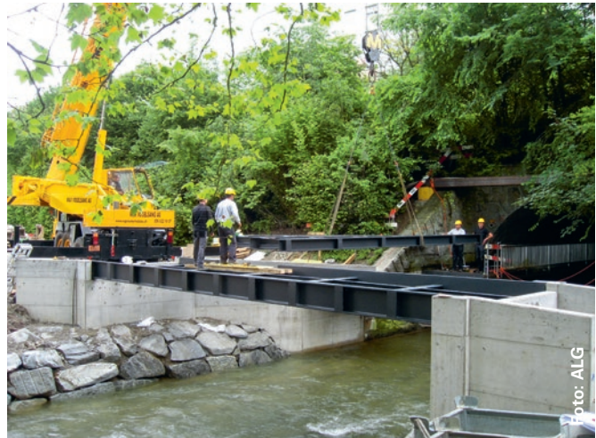
Die alte Brückenplatte der Fussgängerbrücke Junkholz in Wohlen (links) wurde durch einen neuen Stahlbauträger (rechts) ersetzt.
