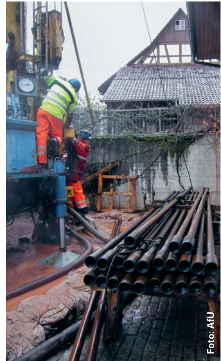
Das Verschliessen der Bohrung wird durch Spezialisten ausgeführt.
