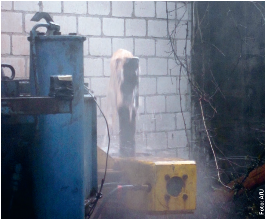
Artesischer Wasseraustritt aus dem Bohrgestänge
