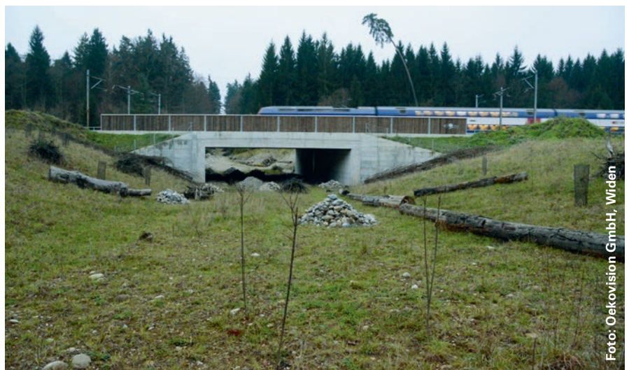
Die Unterführung der SBB-4-Spur-Strecke im Suret-Wald wurde auf 15 Meter verbreitert und für Menschen gesperrt.
