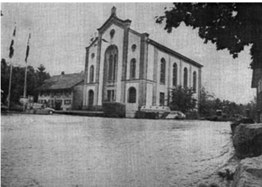
Am 19. Mai 1994 wurde das Dorfzentrum von Lengnau überflutet.
