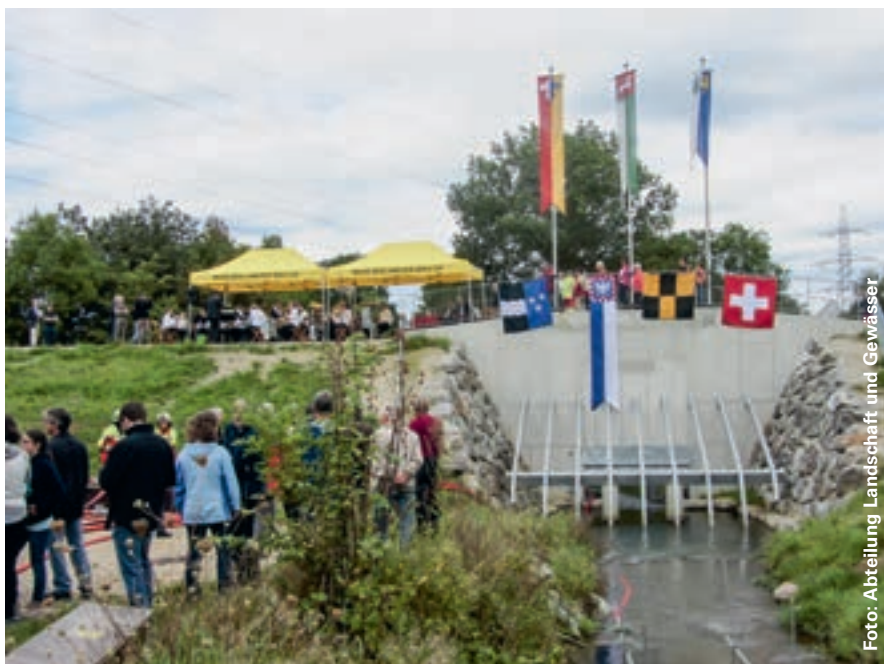
Am 23. August 2014 – genau zwei Jahre nach dem Spatenstich – konnten die Bauwerke in Ehrendingen eingeweiht werden.
