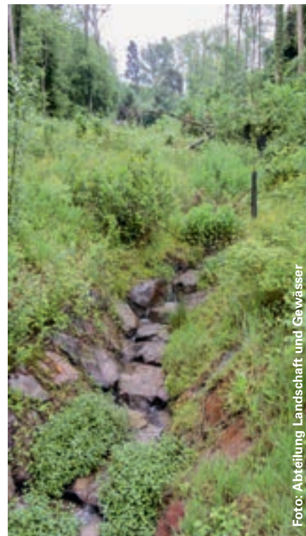
Als ökologische Ausgleichsmassnahme wurde der Haselhölzlibach in Ehrendingen ausgedolt.
