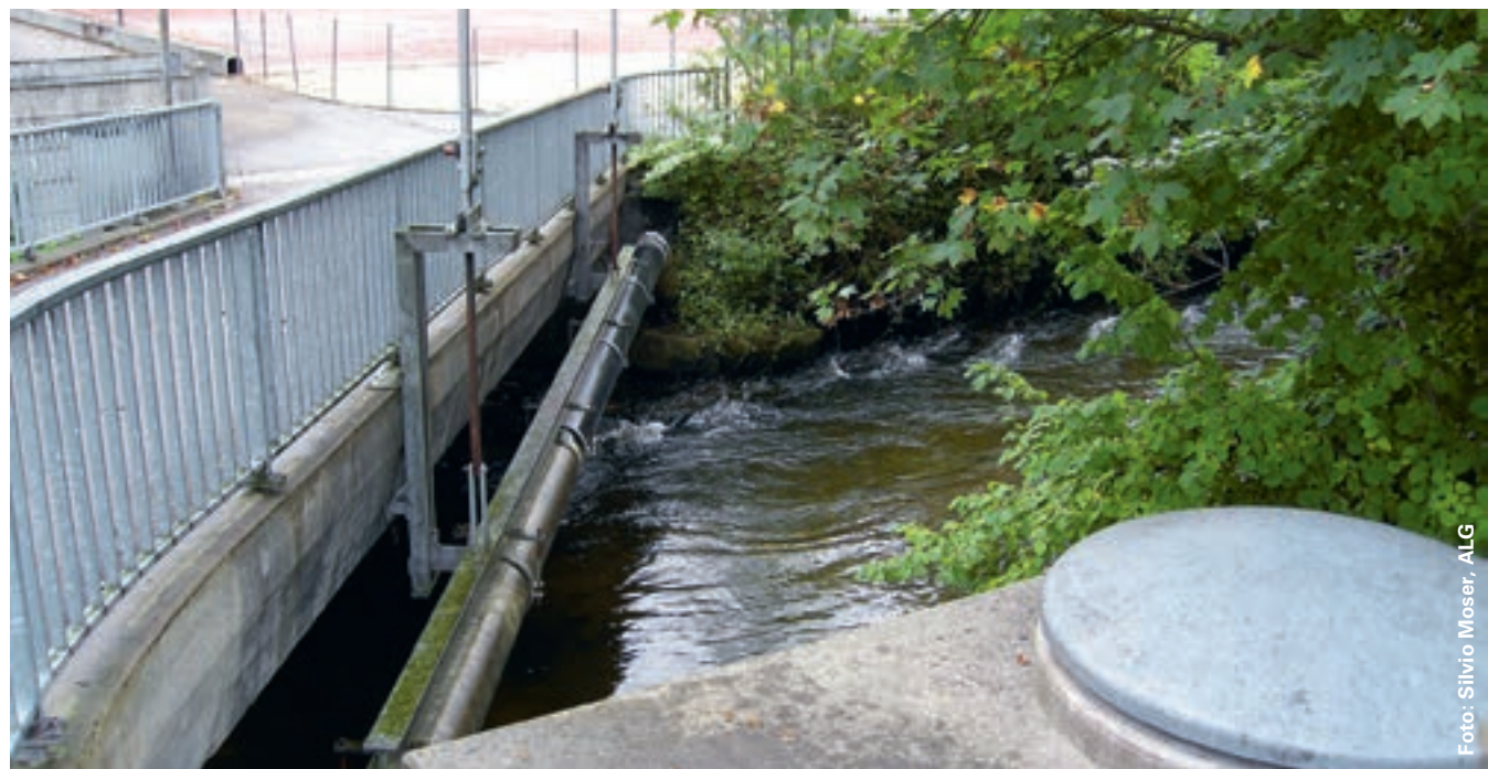
Die Paradiesbrücke in Möriken-Wildegg wird neu gebaut und die Abwasserleitung verlegt.
