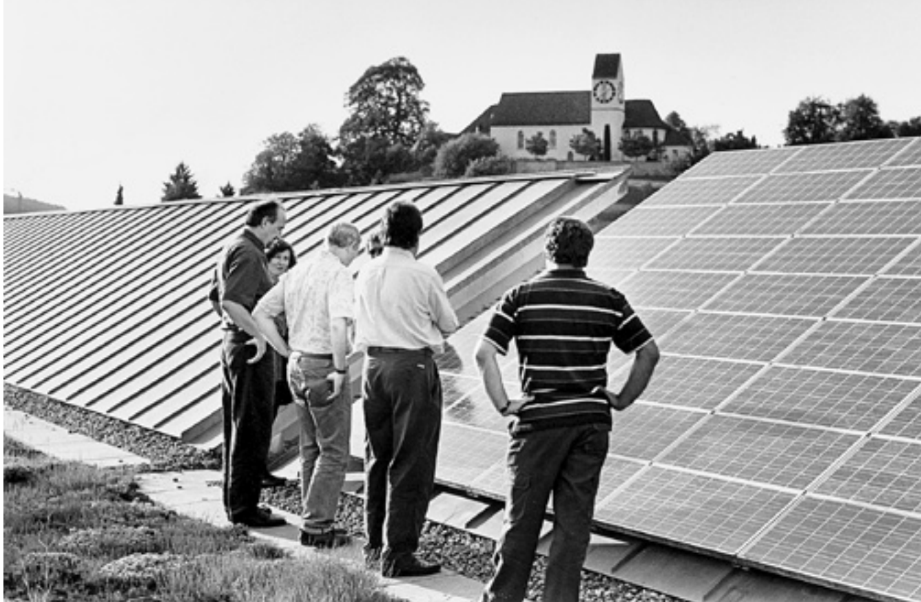
Die Energiekommission von Magden besichtigt die Photovoltaikanlage auf dem Dach des Schulhauses.
