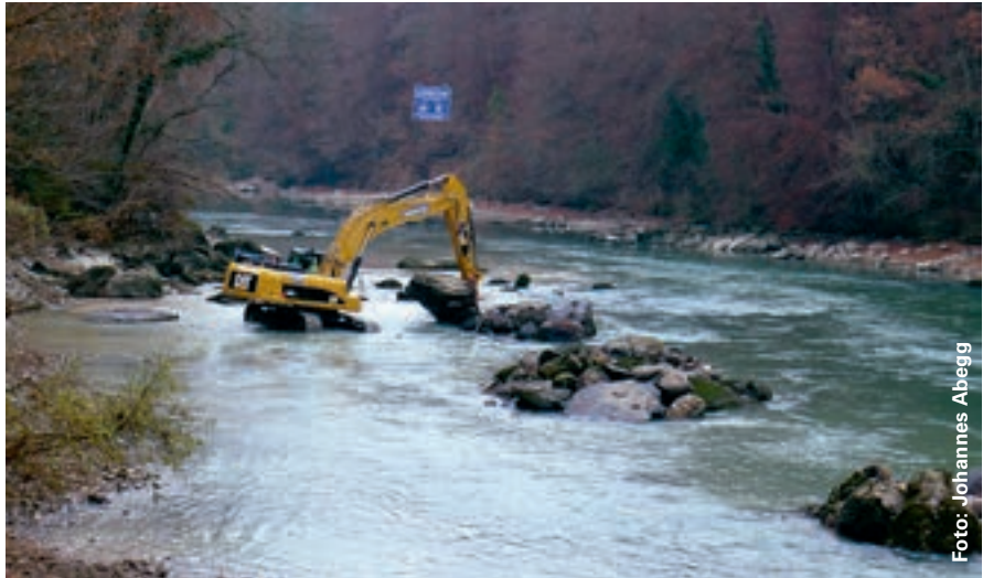
In der Reuss oberhalb von Gnadenthal wurden im November 2011 in einer Linkskurve die im Flussbett verstreuten Felsblöcke zu Inseln konzentriert. Da der Hangfuss von Steinen befreit ist, sind periodische kleine Rutschungen möglich.
